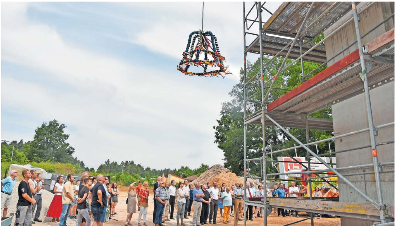
Bunte Bänder an der Richtfestkrone: Sie signalisiert, dass der Anbau an die Anton-Seitz-Mittelschule in seinen Grundzügen steht. Laut Bürgermeister ist der 10,15-Millionen-Euro-Bau ein Bekenntnis zum Bildungsstandort Roth. Foto: Petra Bittner
